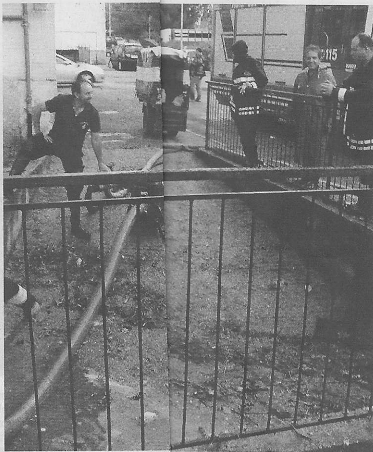
I lavori Via al rifacimento della fognaria al rione Pescara
